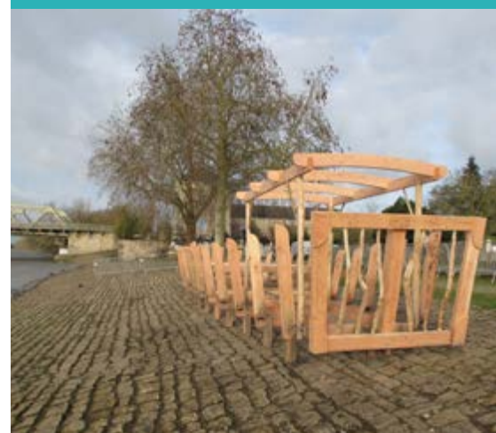
Le chantier quelques heures avant la crue de la Loire
