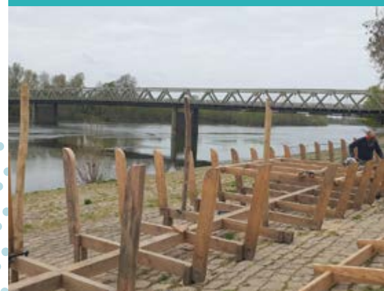
Reprise de l'installation en avril
